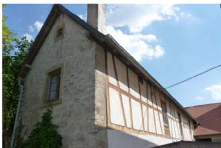
Scheunen und Nebengebäude sind in der Regel im Untergeschoss massiv in Natursteinsichtmauerwerk ausgeführt. Der erhöhte Kniestock in Fachwerk
