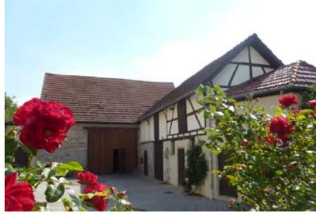
Fachwerk bildet das statische konstruktive Gerüst eines Gebäudes und unterliegt daher Zwängen, die bei der Gestaltung der Fassade zu berücksichtigen sind.
