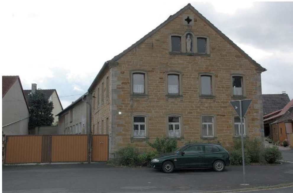
Abb. 12: Typische Gestaltungsmerkmale: Sandsteinfassade und Doppelfenster mit mittig liegender Heiligennische
